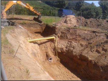
Abb. 3: Durchörterung Lohmener Straße: Errichtung einer neues Rohrdurchlasses, 25.08.2016
